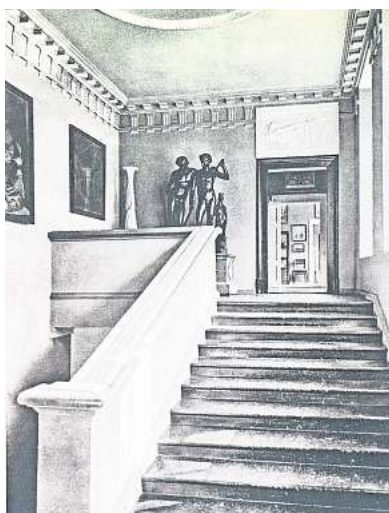
Das Treppenhaus anno 1915.
